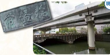
大正15年に竣工した鉄筋コンクリートのアーチ橋。
