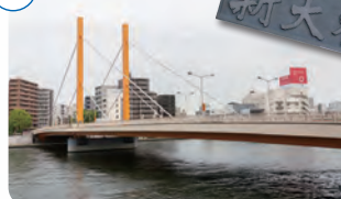
旧新大橋は戦後、橋台の沈下が激しく、昭和52年に現在の斜張橋に。
