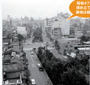
浜町の緑道／中央区撮影(昭和52年)
