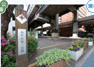
首都高の下には、隣にあった橋にちなんだあやめ第一第二公園。
